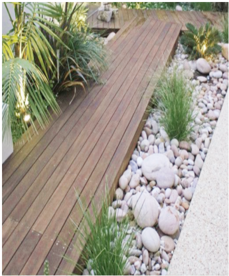
RABATTER I STENKROSS FÖR DRÄNERING
